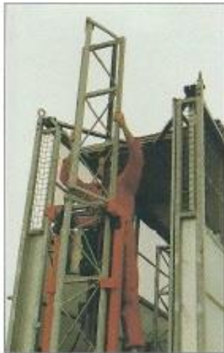
Télescopage des mâts depuis la cabine
