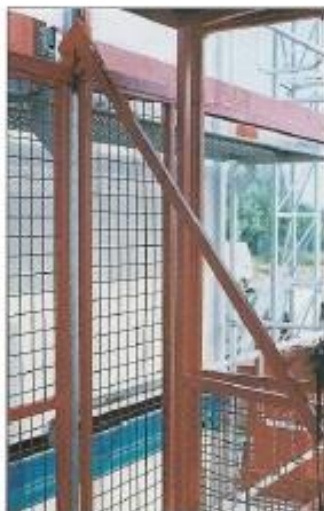
Verrouillage mécanique des portes palières
