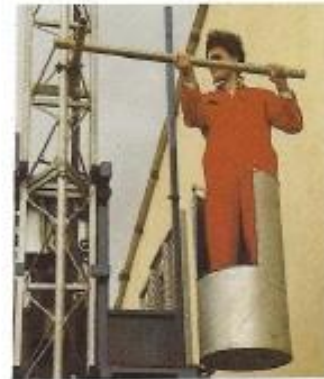
Mise en place des ancrages
