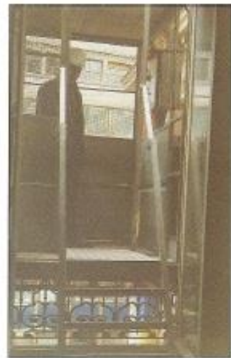
Escalier déployable pour accès direct en bâtiment habité sans démontage de fenêtres et sans installation de portes palières
